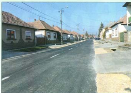
A felújítási munkálatok a kapubejáratokat, árkokat is érintették
