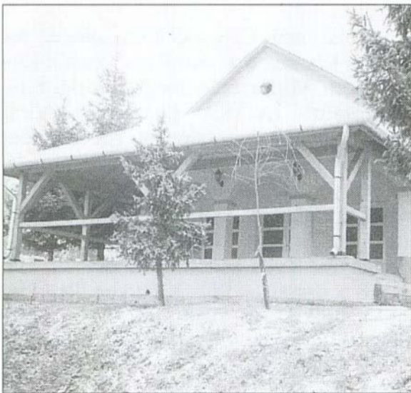
A halottak napjára elkészült a ravatalozó felújítása
