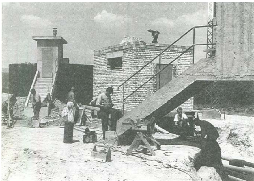
A szennyvíztelep építése 1994-ben
